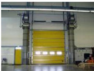
Воздушно-тепловые завесы предназначены для создания организованного потока теплого воздуха, направленного от боковых сторон открытых ворот зданий и сооружений, с целью уменьшения возможности проникновения наружного воздуха в помещение в холодное время года.
